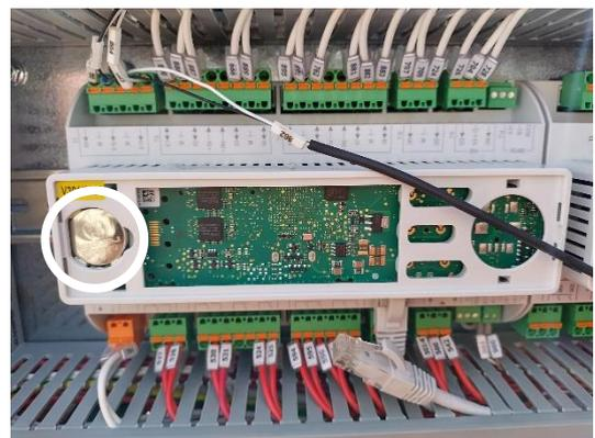
Seien Sie vorsichtig, damit die Kunststoffabdeckung nicht beschädigt wird. Dann die neue Batterie ordnungsgemäß in die Halterung (siehe markierter Bereich auf der nachfolgenden Abbildung) einsetzen und dabei auf die richtige, in der Halterung gekennzeichnete Polarität achten.
