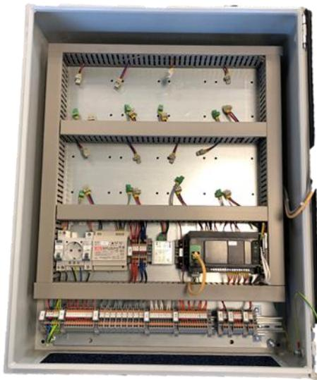
Die Steuerung der Chiller und FanCoils läuft bei Anschluss der Kanalgeräte 100% getrennt.
