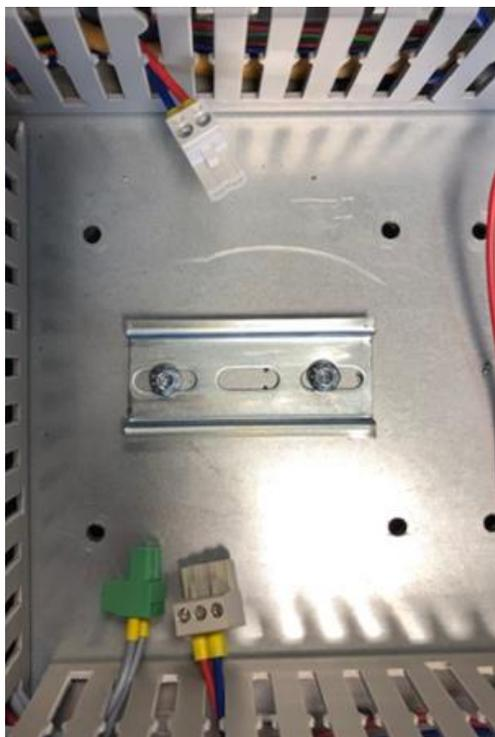
Schiene der DCOM Platine anschrauben
