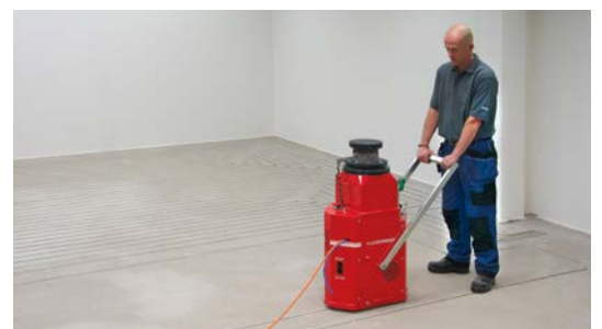
DAIKIN cut: Die Kanäle zur Verlegung der Heizrohre werden in den vorhandenen Estrich eingefräst.
