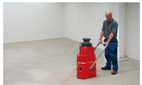
DAIKIN cut: Die Kanäle zur Verlegung der Heizrohre werden in den vorhandenen Estrich eingefräst.
