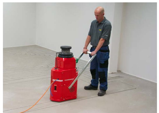
DAIKIN cut - Die Kanäle zur Verlegung der Heizrohre werden in den vorhandenen Estrich eingefräst
